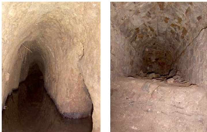
Des aqueducs, creusés dans le tuf, parfois maçonnés ...
