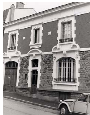
Pierres de taille + moellons apparents ou/et briques + enduit
