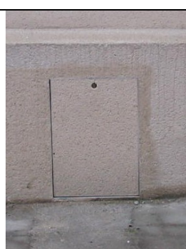
Encastrement avec dispositif habillable, avant-après
