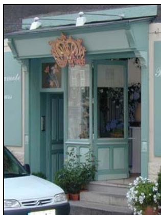
Ci contre, un exemple d'adaptation qui peut être autorisée : une porte d'accès aux étages a été créée, mais en respectant l'esprit de l'architecture d'origine de la devanture
