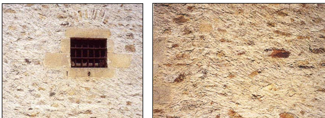
enduit « à pierres vues » (source : « Les murs et les enduits en Limousin » DRE DRAE 1989)
