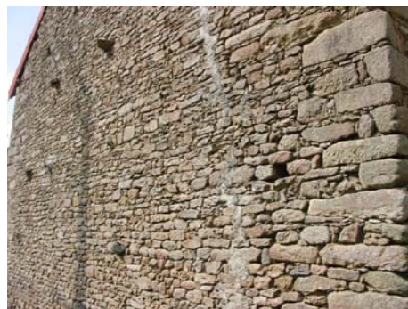
Limousinage (ou limousinerie)
