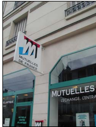
de même qu'une implantation en retrait de la façade (5 à 15 cm du nu)
